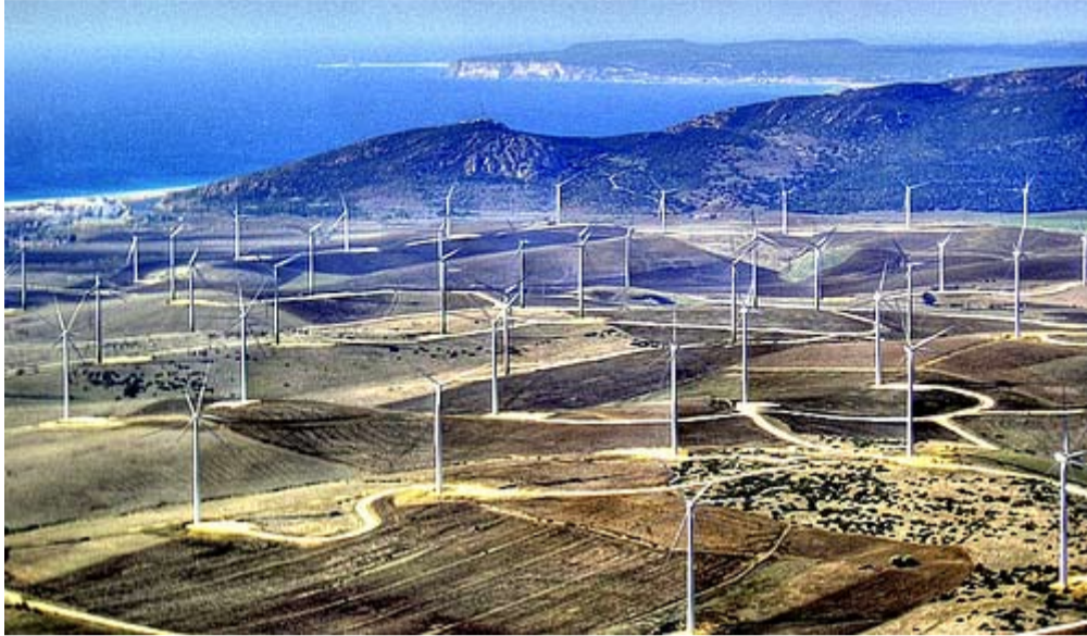
Fotografía parque eólico Tarifa
